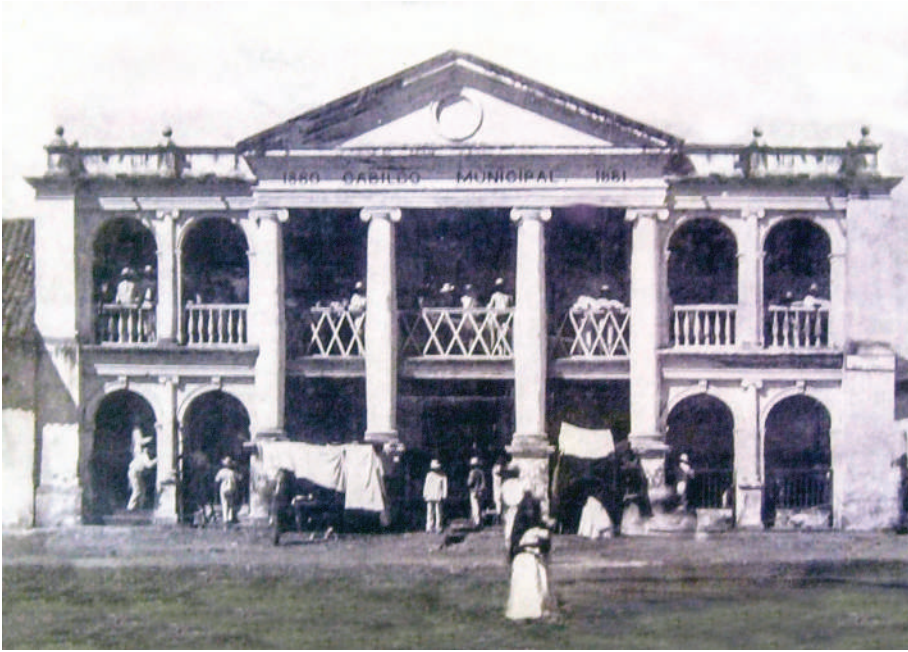
Fachada del Cabildo Municipal de Comayagua, durante los 1930´s.
