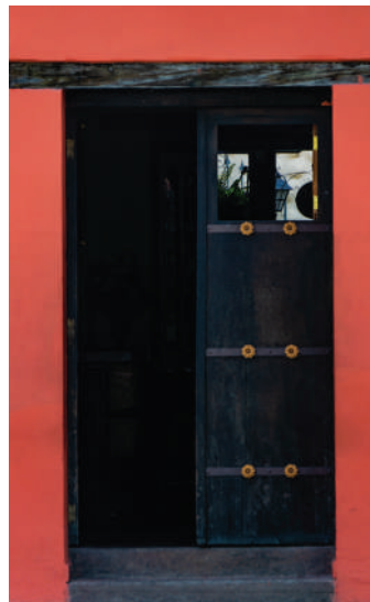
Puerta de dos hojas y marco con dintel de madera, en casa colonial.
