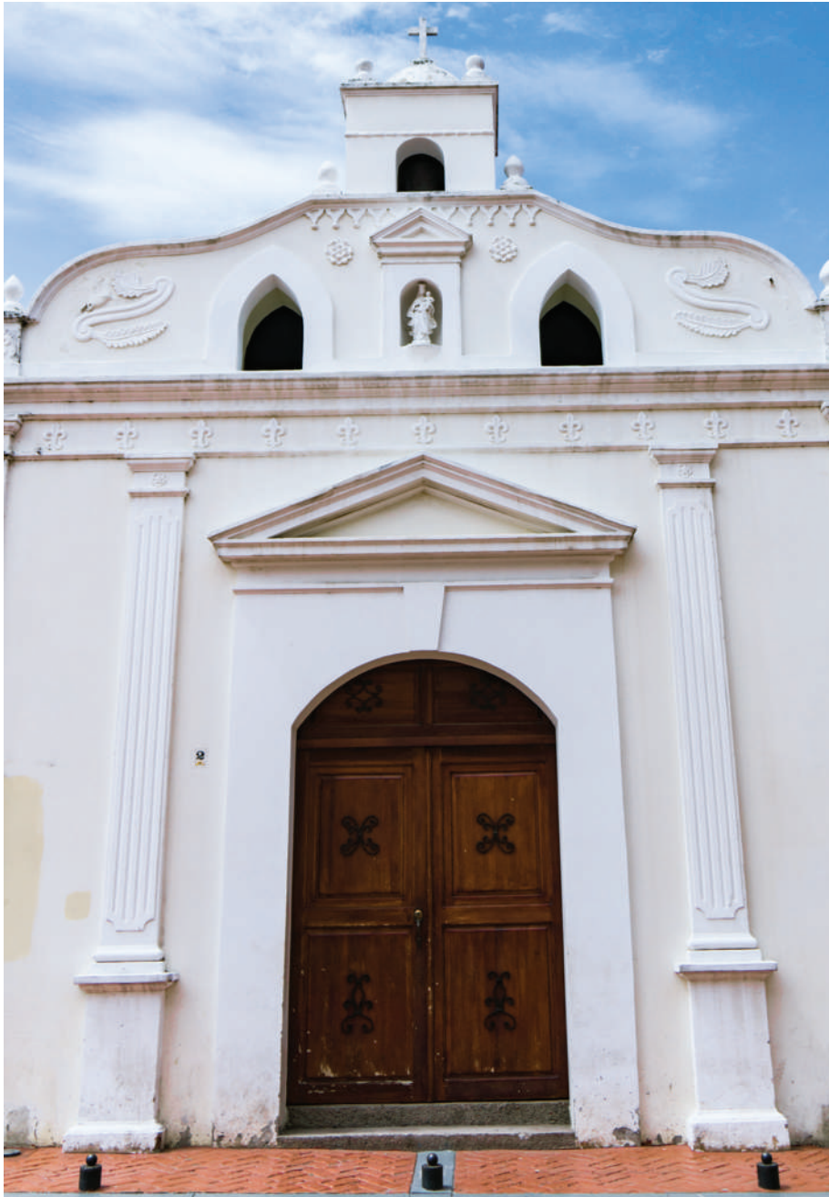
Fachada del Palacio Episcopal de Comayagua, elaborada en estilo neoclásico y barroco, combinados.
